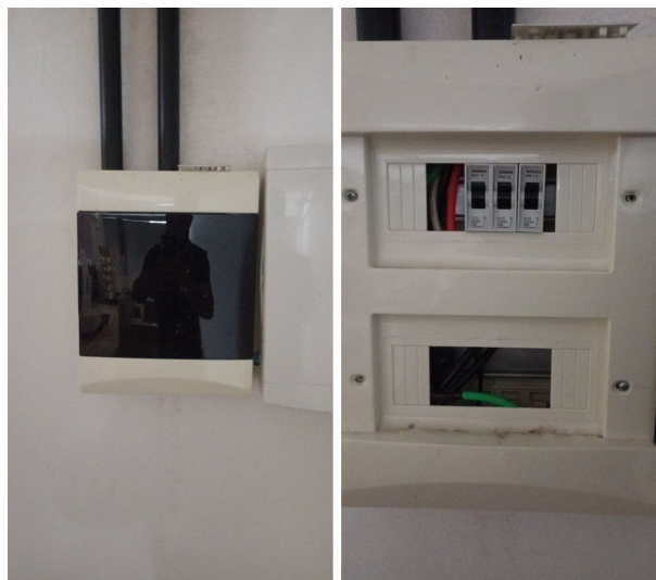
Figura 2: Quadro de distribuição existente (QD1).
